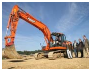
Symbolischer Baggerstich für die Biogasanlage auf dem Gelände an der K 246. (Foto: pe)
